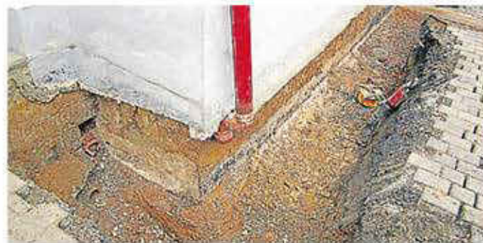
Hier ist ein freigelegter Haussockel/Wärmedämmverbundsystem zu sehen.
