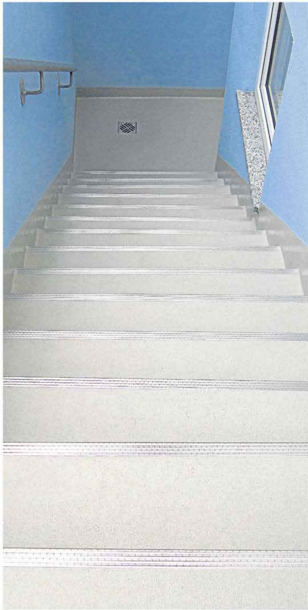
Nach den Arbeiten erstrahlt die Treppe in neuem Glanz.
