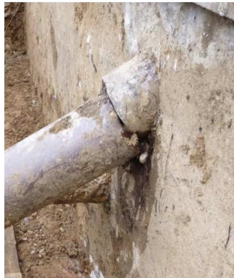
Fall 2: Alte beschädigte Steinzeugrohre werden durch Kunststoffrohre ersetzt. Die Anschlussabdichtung wird als umlaufender Kehlanschluss mit kunststoffmodifizierten Bitumendickbeschichtung hergestellt.
