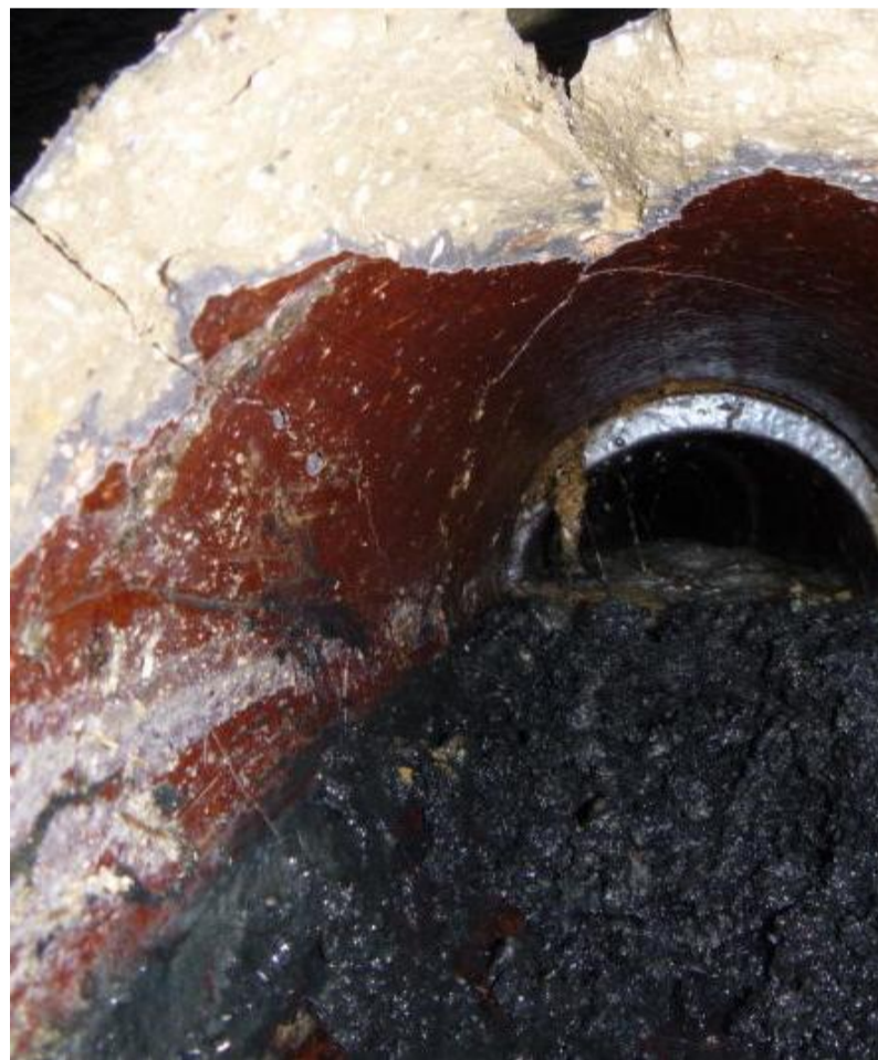
Fall 2: Alte beschädigte Steinzeugrohre werden durch Kunststoffrohre ersetzt. Die Anschlussabdichtung wird als umlaufender Kehlanschluss mit kunststoffmodifizierten Bitumendickbeschichtung hergestellt.
