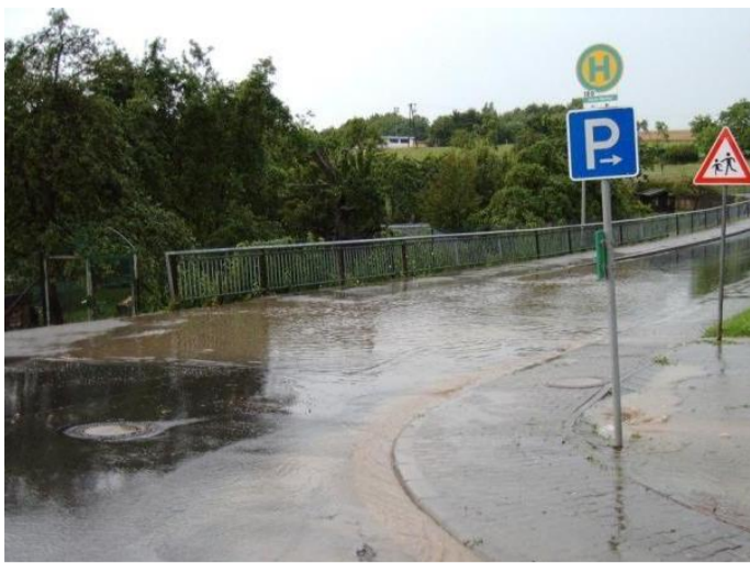
Straßenüberschwemmung durch Abwasserrückstau in der Kanalisation. Ohne Rückstausicherung können auch die Keller der umliegenden Häuser überschwemmt werden. Foto: Georg Neu
