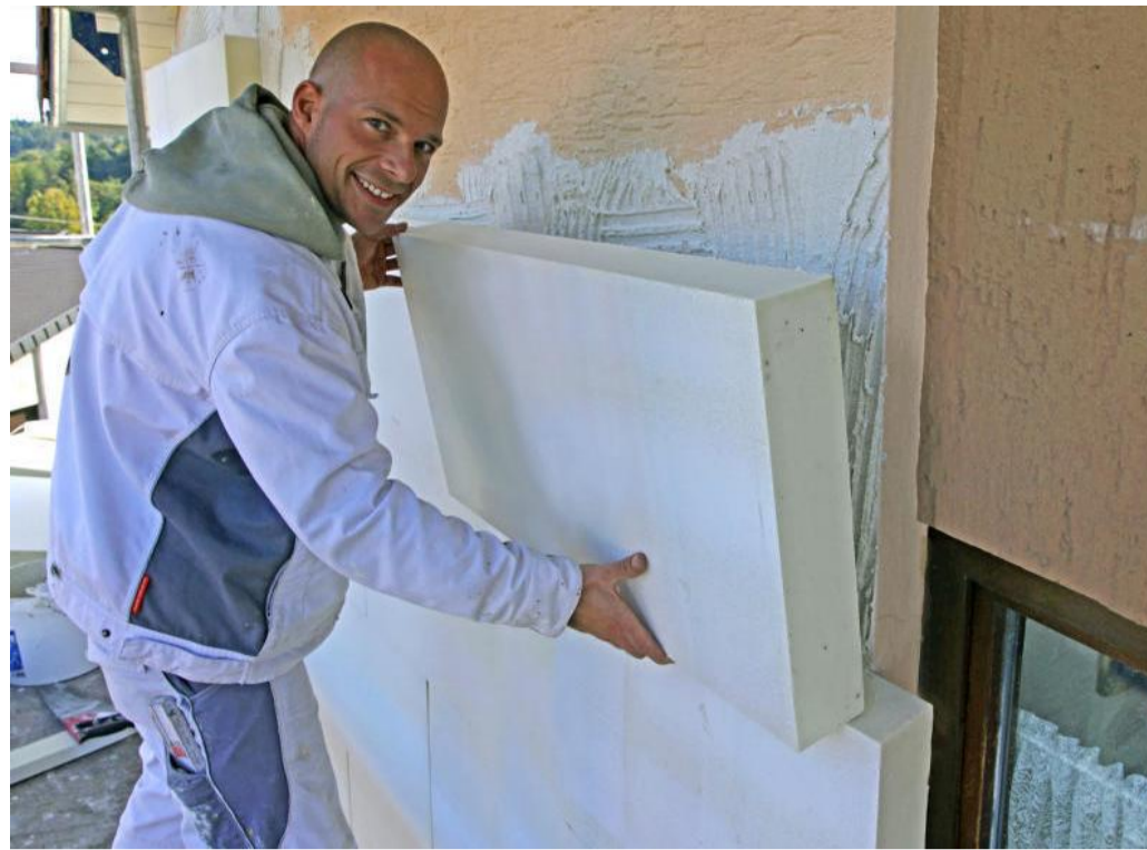
Je leistungsfähiger das Dämmmaterial, desto schlanker kann eine Wärmedämmung ausgeführt werden. Foto: djd/puren
