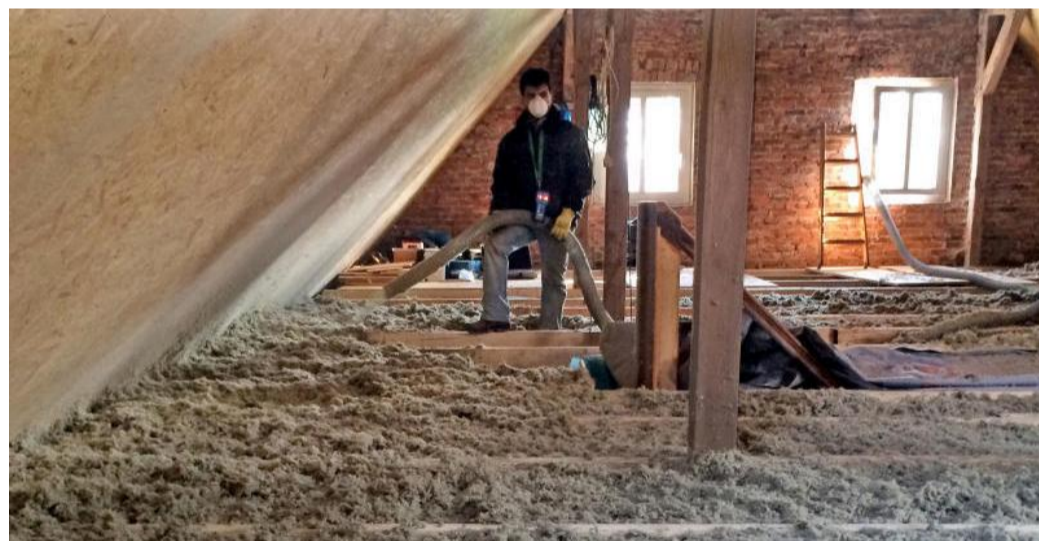
Eine Einblasdämmung mit Steinwolle eignet sich hervorragend für den Einsatz im Dachboden. Foto: djd/www.ecofibre.de
